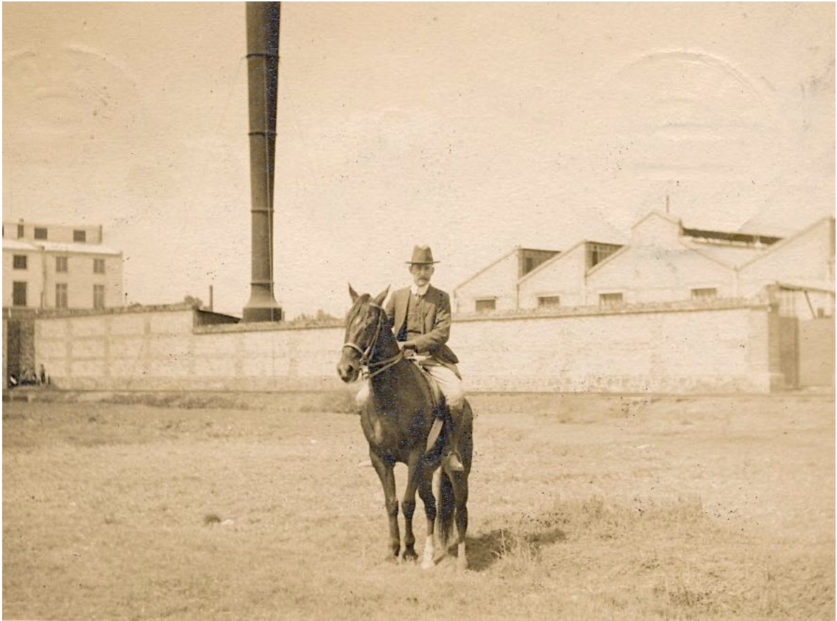
Afinador dit « Le Chargeur », monté par son maître devant l'usine Afinadora de Metales. Mai 1910.
